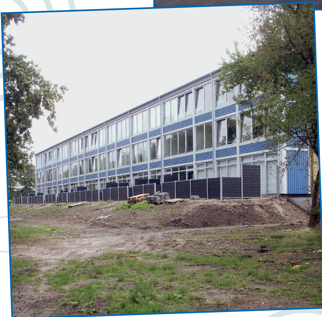
Der arbejdes med de nye terrasser, der erstatter haverne.
