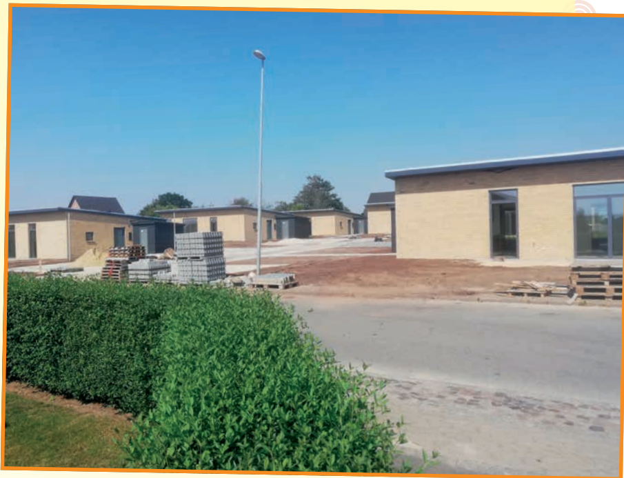
De seks nye boliger på Kærvej i Tjæreborg er snart klar til indflytning.
