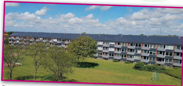
Det nye skifertag og facaderenovering har givet blokkene i afdeling 2-3-4 et helt nyt udseende.
