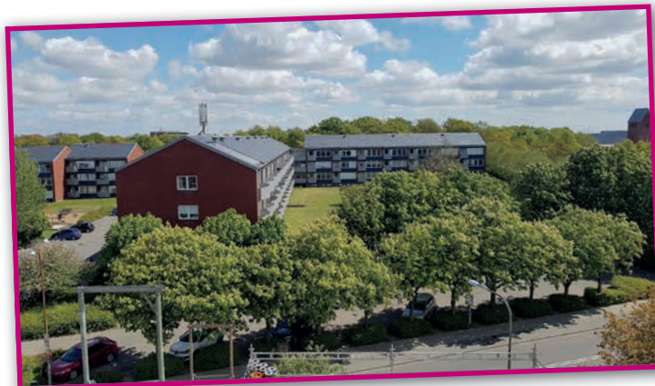
Nyt ovenlys har givet bedre lysforhold og akustik i opgangene. Blokkene har desuden fået solceller på taget.
